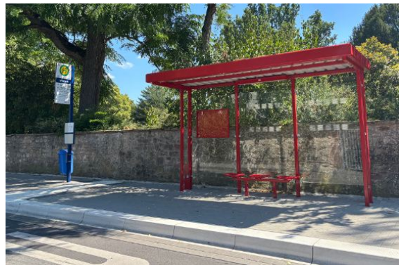
Beispielbild für eine modernisierte barrierefreie Bushaltestelle. Foto: Stadt Weinheim
