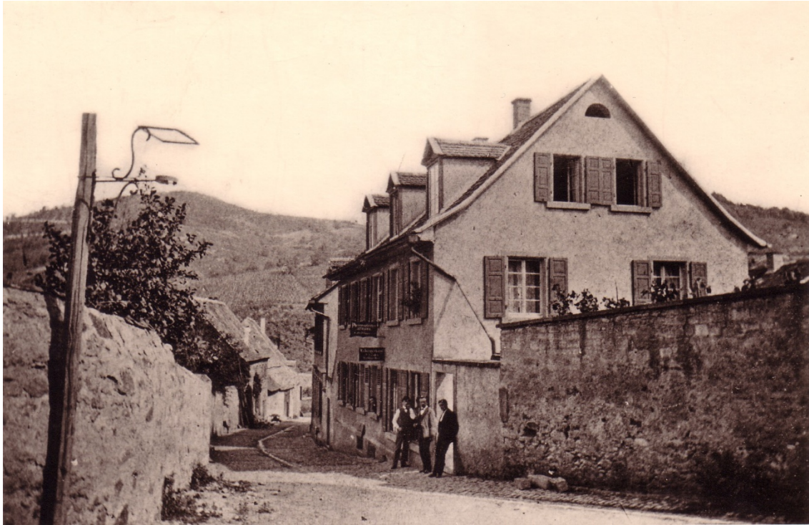
Abb. 1 Grabengasse, um 1890. Links: Gartenmauer Institutstraße 15.
