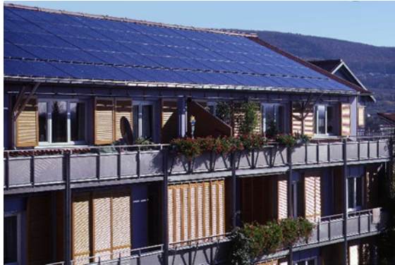
PV-Anlage auf einem Mehrfamilienhaus
