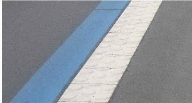
**Abbildung 2: Trennung RSV zum Fußverkehr über taktile Elemente**
